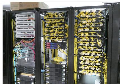
コアスイッチ群(AX8600S、AX3660S)と端末を直接接続するFTTD構成
